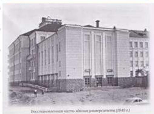
Восстановленная часть здания университета (1949 г.)
